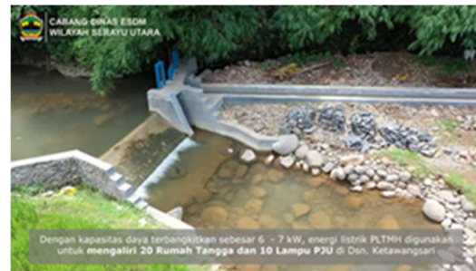
Gambar 4 Bendung intake PLTMH Gringgingsari (Cabang Dinas ESDM Wilayah Serayu Utara, 2023)
