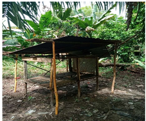
Gambar. 3 Kondisi Bangunan Usaha Ayam Potong Samu' Adup
